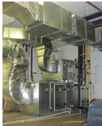
Система аккумуляции холода в системе кондиционирования воздуха
