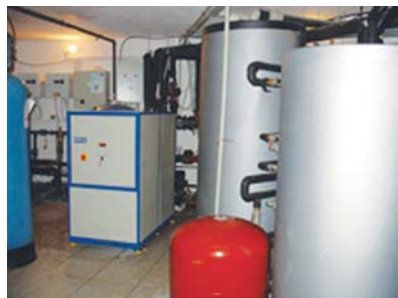
Гибридная теплонасосная система теплохладоснабжения многоэтажного здания
