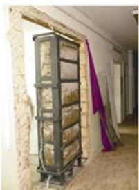
Теплоаккумулятор СТЭ типа «Стена» в собранном виде без кожуха
